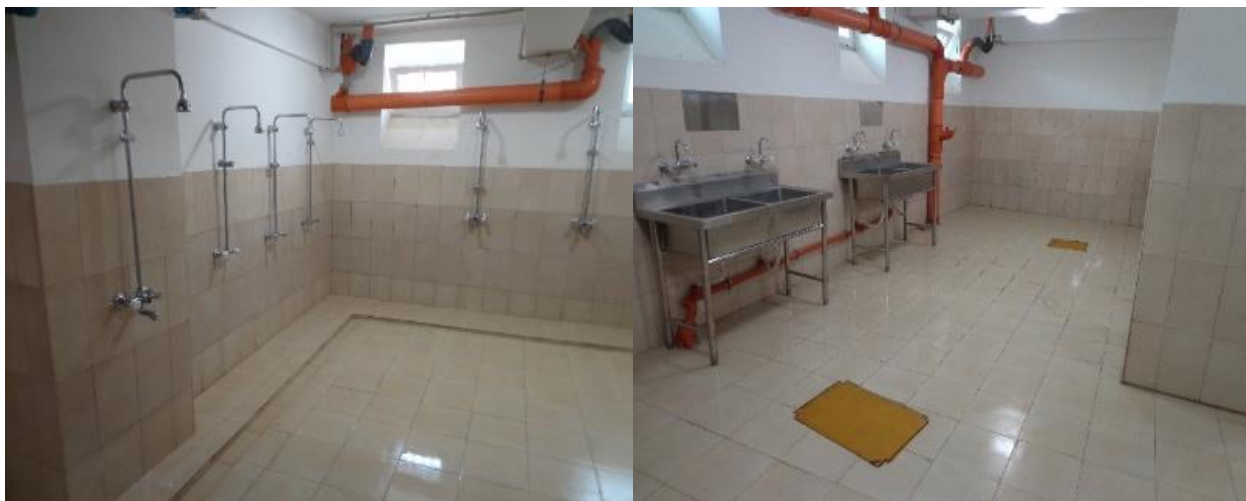
Ремонтираната обща баня
